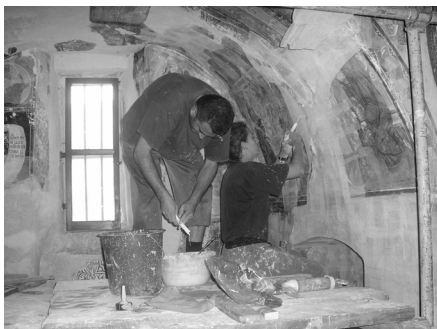
Slika 12. – Injektiranje
