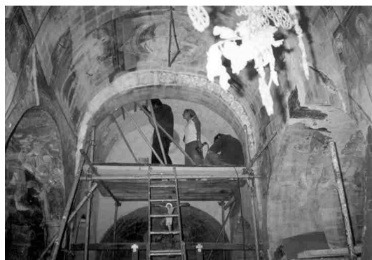
Slika 8. – Vraćanje fresaka
