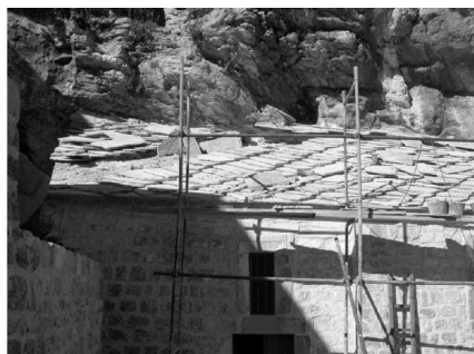
Manastirska crkva Zavala restauracija krova i riznice, popravka pukotina
