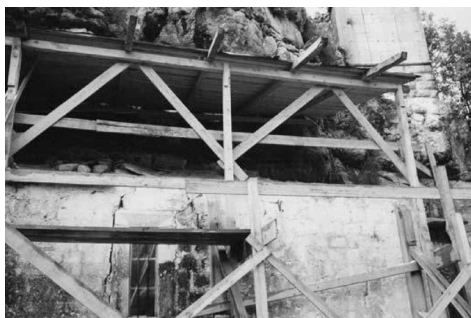
Manastirska crkva Zavala restauracija krova i riznice, popravka pukotina
