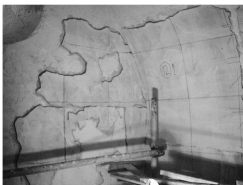
Slika 9. – Vraćanje fresaka na prvobitnu poziciju
