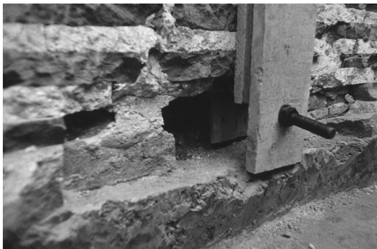
Slika 6. – Otvori za provetranje
