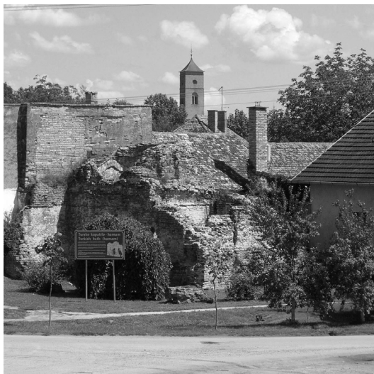
Slika 10. – Pogled na ostatke hamama iz pravca tvrđave (foto: S. Vujović)
