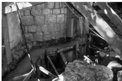
Manastirska crkva Zavala projekat mikro-pilinga radi ojačavanja temelja 2001. godine
