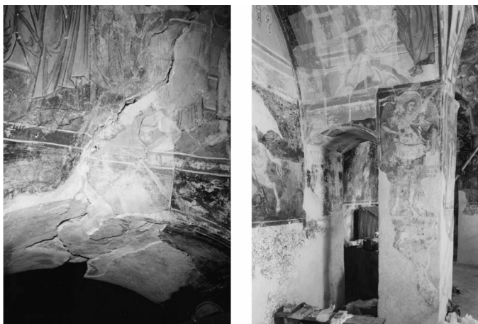
Manastirska crkva Zavala pukotine na unutrašnjosti 2000. godine
