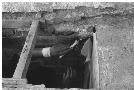
Slika 9. – Lepljenje flastera
