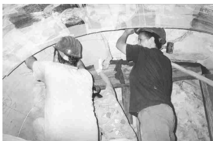
Slika 6. – Skidanje fresko slikarstva
