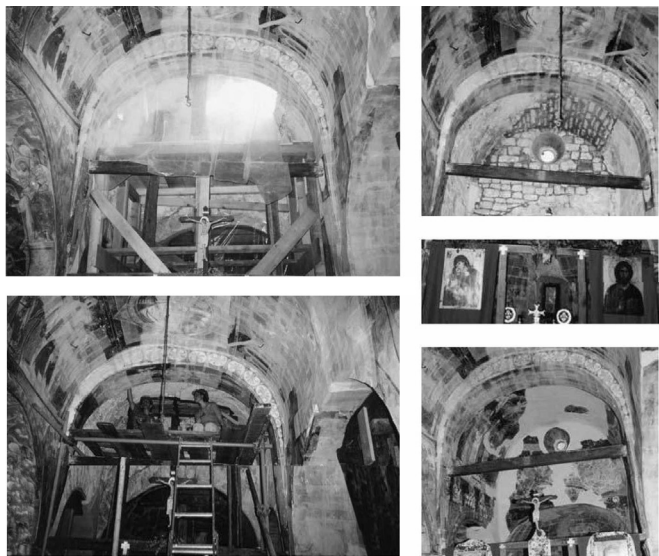
Manastirska crkva Zavala restauracija krova i svoda, popravka pukotina
